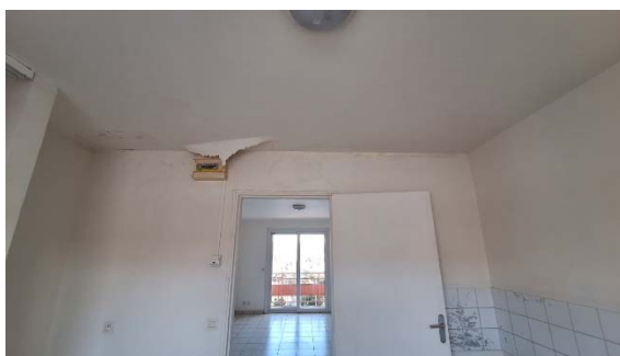
Photo 13. Infiltration dans la cuisine de l'appartement
