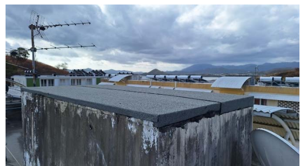
Photo 10. Vue sur étanchéité de couverture des cuves
