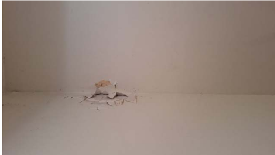
Photo 15. Traces d'infiltrations dans salon et salle de bain
