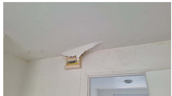
Photo 13. Infiltration dans la cuisine de l'appartement
