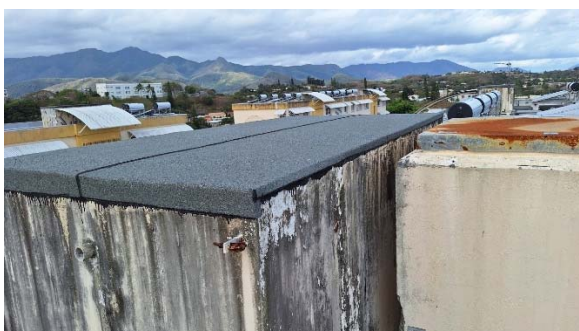
Photo 10. Vue sur étanchéité de couverture des cuves
